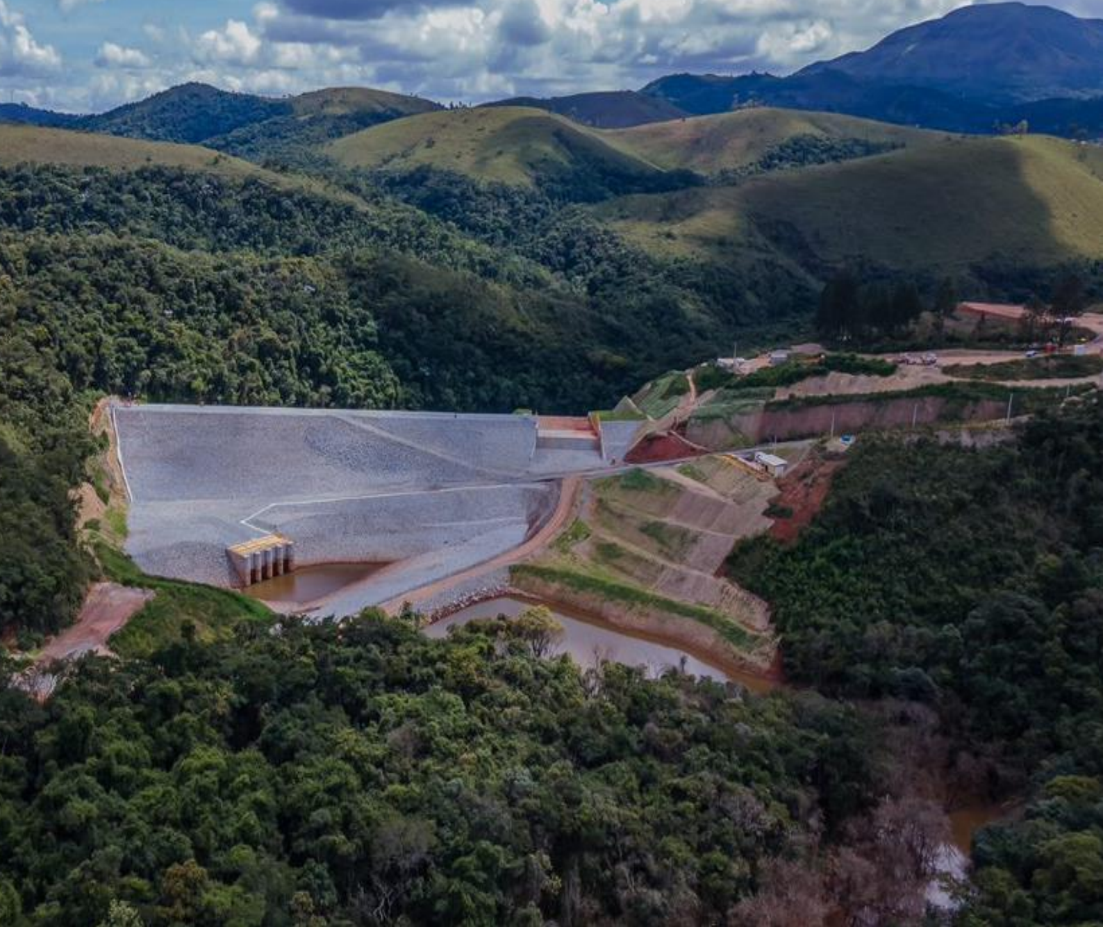
Estrutura de contenção da barragem B3/B4, concluída no 4T20
