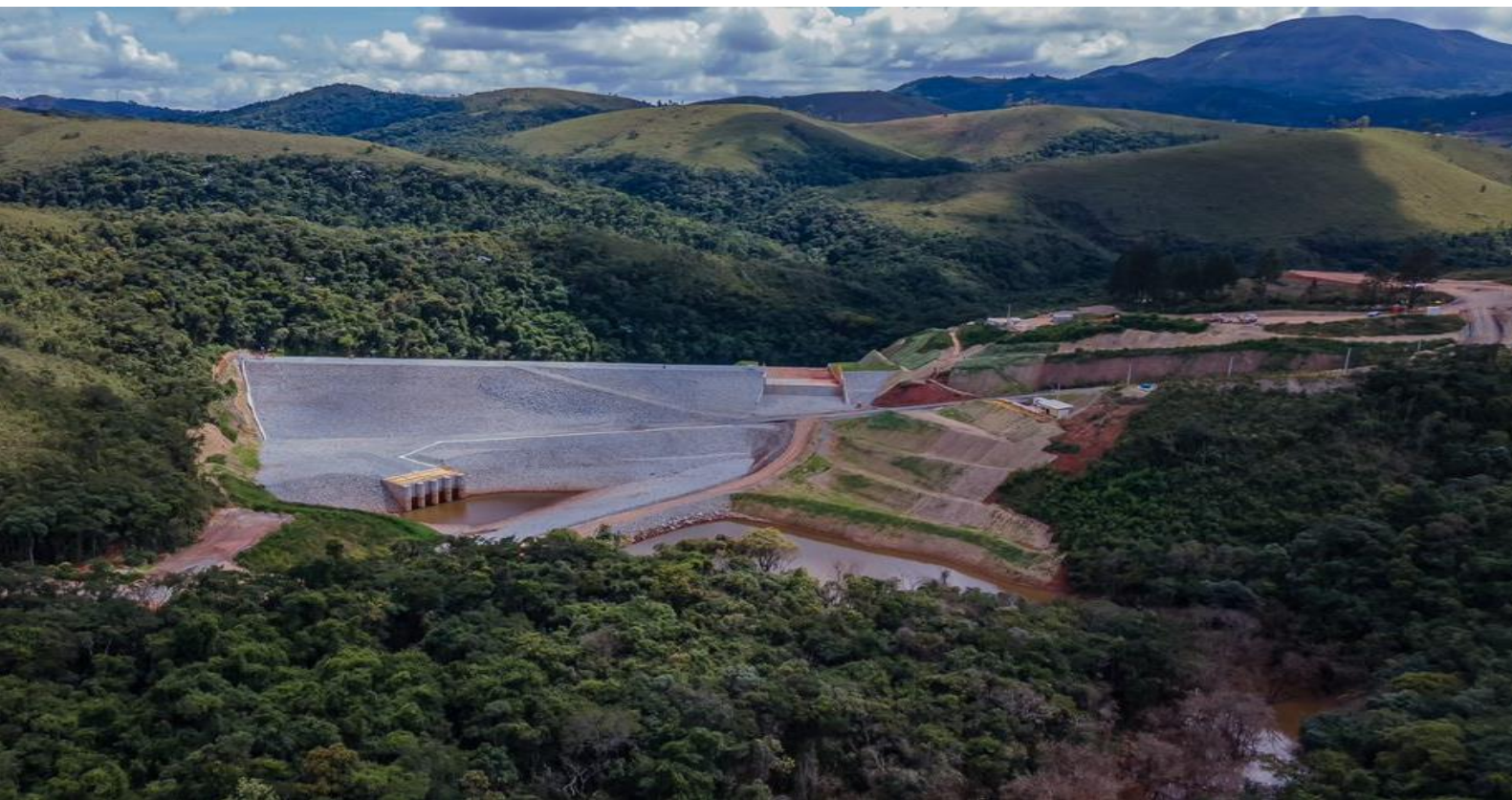
Estrutura de contenção da barragem B3/B4, concluída no 4T20
