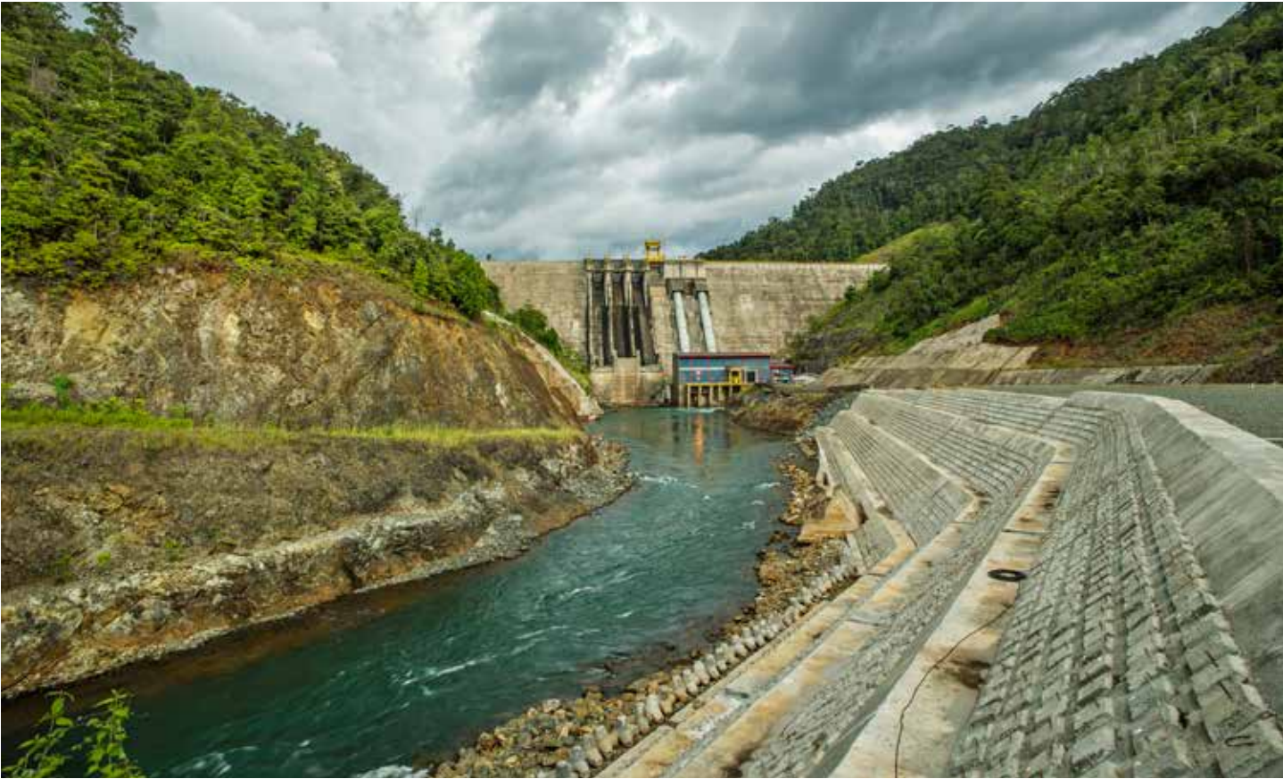
▲ Bendungan PLTA Balambano dengan kapasitas 110 MW Balambano Hydro Power Plant with 110 MW capacity
